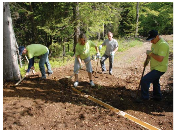
Jednou z dôležitých úloh bolo osadenie dreveného žľabu, ktorý pomáha odvieť stekajúcu vodu z trate. Pri práci zľava doprava: Vladimír Dorko, Lucia Petrovičová, Róbert Nemčík a Milan Sciranka.
