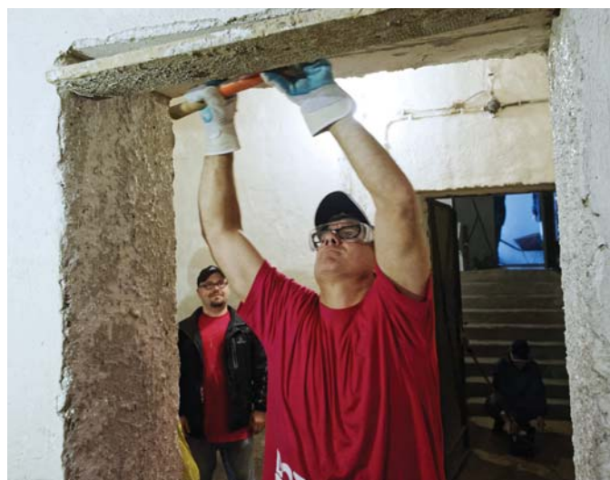
Prezident U. S. Steel Košice Scott Buckiso využil návštevu v botanickej záhrade na krátke stretnutie so zamestnancami a zároveň pomohol aj pri oprave zárubne v pivničných priestoroch.
