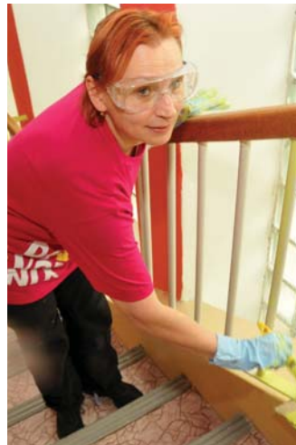
Anna Gáborová z DZ Radiátory a rúry pri maľovaní zábradlia schodišťa v budove detského domova.
