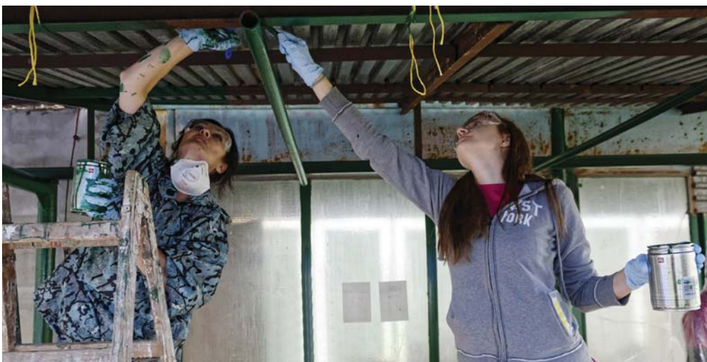
Gabriela Adamová (vľavo) a Jana Petrášová očistili staré nátery vonkajšej kovovej konštrukcie spojovacej chodby a znovu ich natreli.
