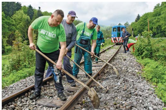
Štrkovanie podvalov na trati.
