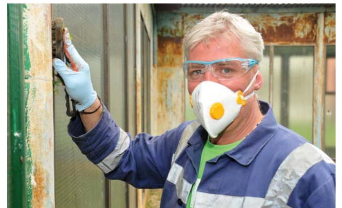
Róbert Lakatos z Údržby pri čistení kovovej konštrukcie od hrdze.
